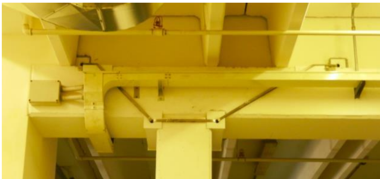
Figura 33 – Edil CAM SISTEMI: interventi di connessione pilastro-trave
