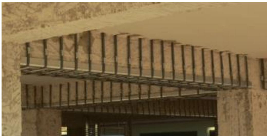
Figura 19 – Rinforzo della trave in completo avvolgimento: angolari continui all'intradosso
