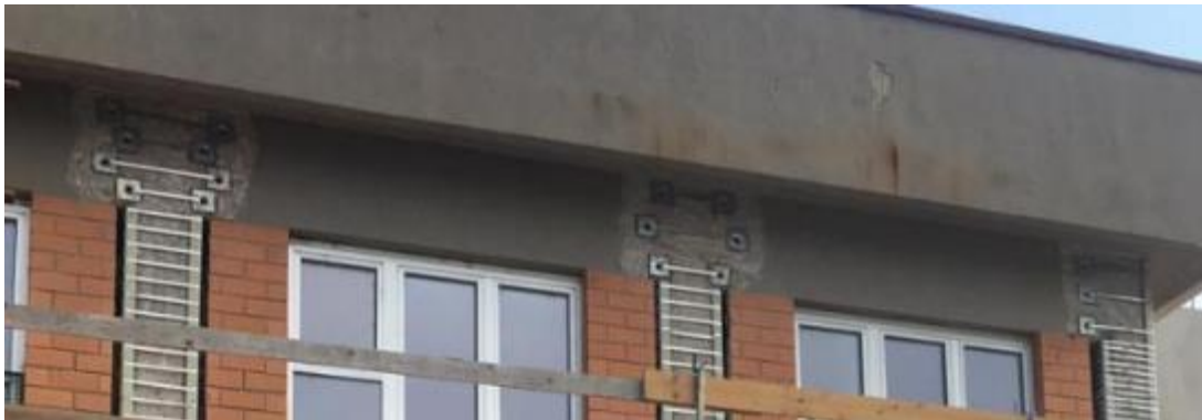
Figura 24 – Edil CAM SISTEMI: Dettaglio 3d di rinforzo di nodo
