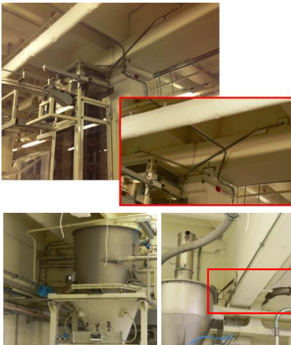
Figura 31 – Edil CAM SISTEMI: generale e dettaglio di interventi di connessione pilastro-trave
