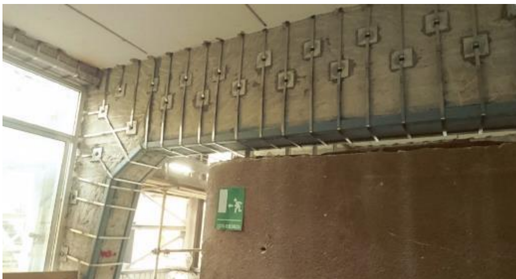
Figura 22 – Vista all'intradosso di una trave alta: si possono realizzare fori intermedi nella trave per andare a costituire staffe a più braccia (principalmente nel caso di travi a spessore) o per incrementare il confinamento della sezione.
