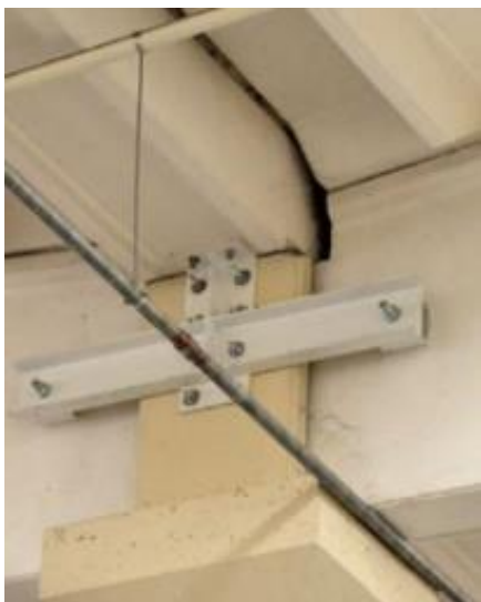
Figura 26 – Carpenteria metallica per realizzazione dei vincoli
