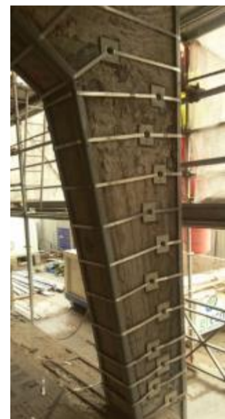
Figura 18 – Pilastro di dimensione variabile durante le fasi di applicazione di posa e tesatura del nastro
