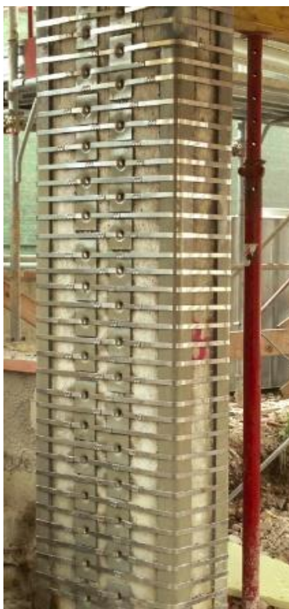
Figura 13 - Edil CAM SISTEMI: Pilastro con 'staffatura' a più braccia
