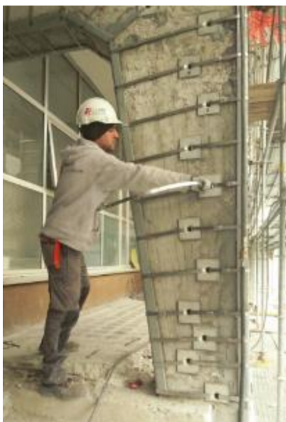
Figura 18 – Pilastro di dimensione variabile durante le fasi di applicazione di posa e tesatura del nastro
