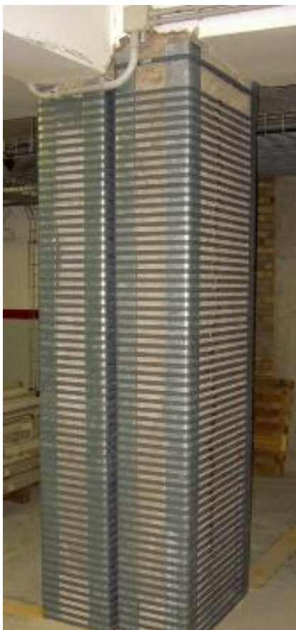
Figura 12 – Edil CAM SISTEMI: rinforzo pilastri in corrispondenza di un giunto strutturale
