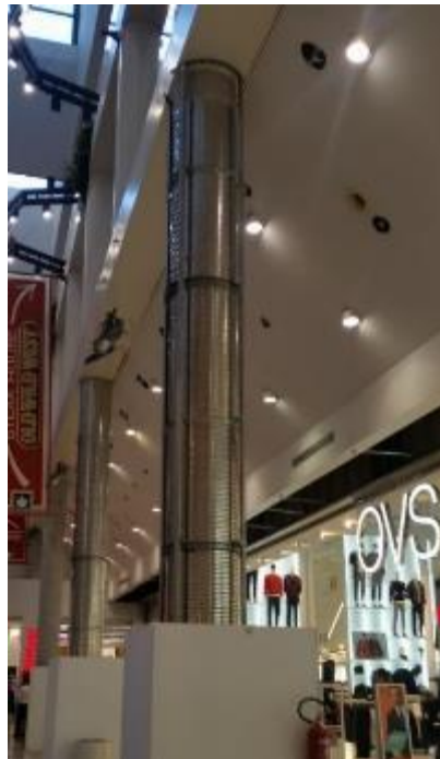
Figura 16 – Edil CAM SISTEMI: Pilastro circolare rinforzato in un centro commerciale senza interruzione dell'attività
