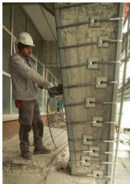
Figura 18 – Pilastro di dimensione variabile durante le fasi di applicazione di posa e tesatura del nastro
