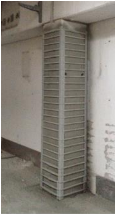
Figura 15 – Edil CAM SISTEMI: Pilastro in corrispondenza di pannelli perimetrali non rimossi
