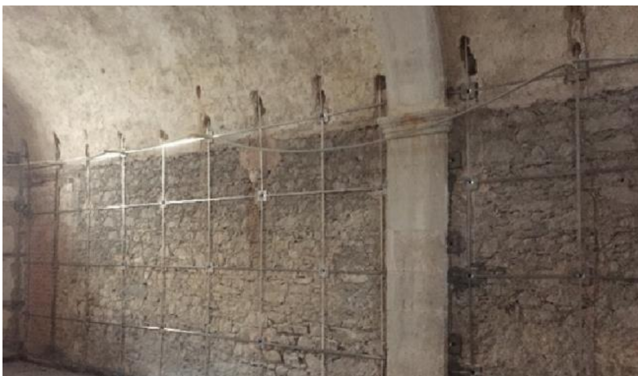
Figura 1 – Edilizia storica e vincolata in muratura
